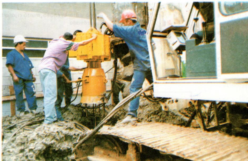
Foto 3.1: Instalação de armadura com vibrador
