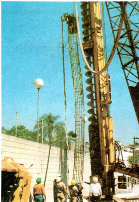
Colocação da armadura de 12m com vibrador.
